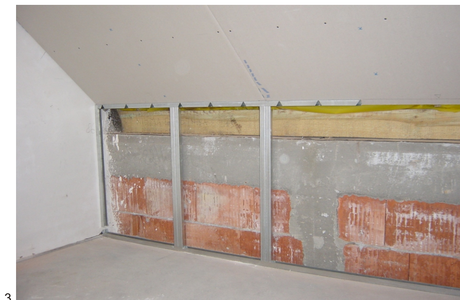
W systemach V w narożniku montujemy profil CD-60 na zawiesiach.
