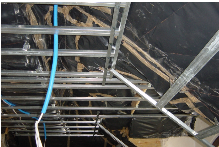
3. PROFIL-V montujemy na pchełki do sufitu i po wytyczeniu następnie go odkręcamy.
