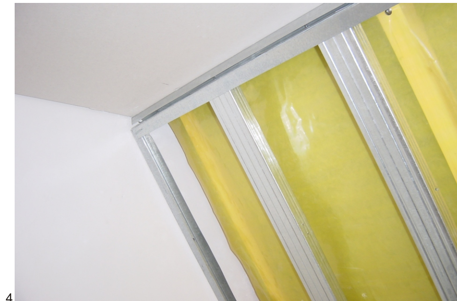
Przykład kombinacji szybkiego montażu PROFILI-V i UD30 połączonych ze sobą na pchełki z sufitu i ścianki kolankowej.
