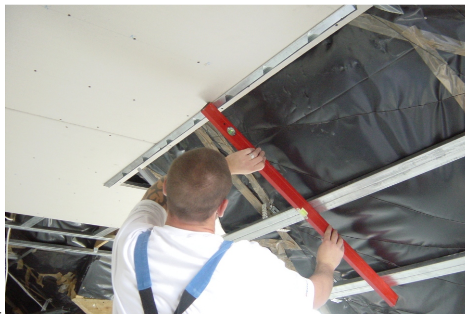
4. Po zamontowaniu płyt montujemy PROFIL-V.
