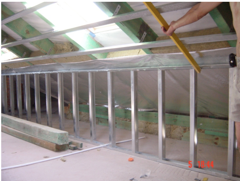
1. PROFIL-V montujemy na pchełki w poziomie do ścianki kolankowej i wytyczamy skos.
