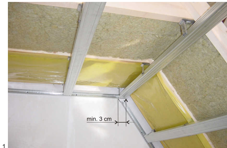
W systemach V w narożniku montujemy profil CD-60 na zawiesiach.
